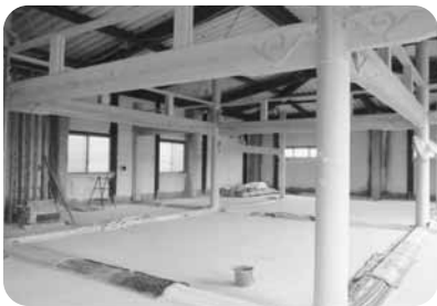
建築中の本堂内部
