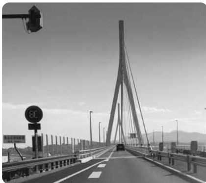
気仙沼横断橋（鼎大橋）
