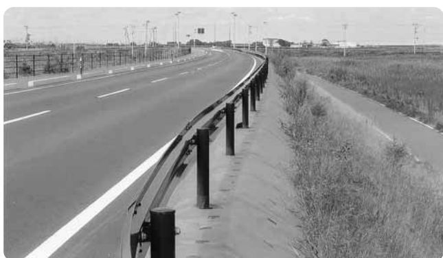
波を遮断する為の新道路
